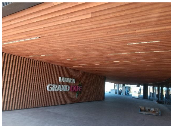
Ilustración 4 Vista del acceso principal
