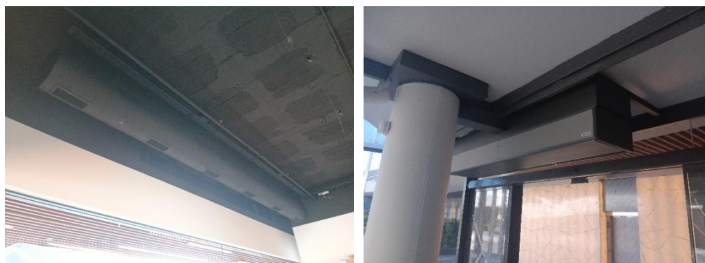
Ilustración 15 Espacios interiores climatizados
